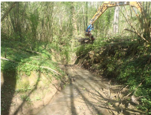
Restauration du tronçon ALC en cours
