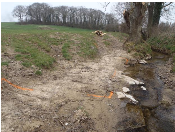
Piquetage d'un abreuvoir rustique
