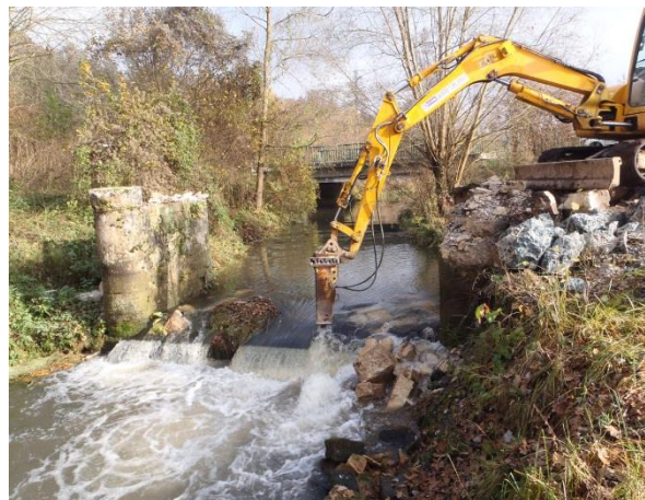
Exemple d'arasement de seuil (restauration de la continuité écologique)
