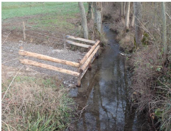
Exemple d'abreuvoir rustique (lutter contre le piétinement du bétail)
