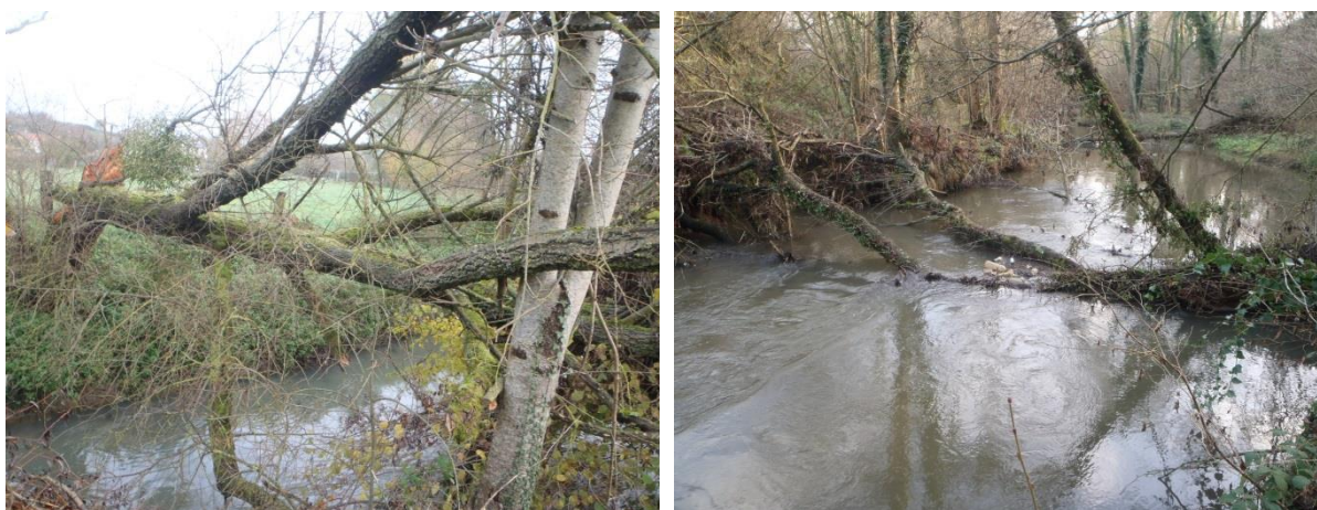
Exemples de travaux d'entretien du lit et des berges (gestion sélective des arbres et retrait des obstacles à l'écoulement)
