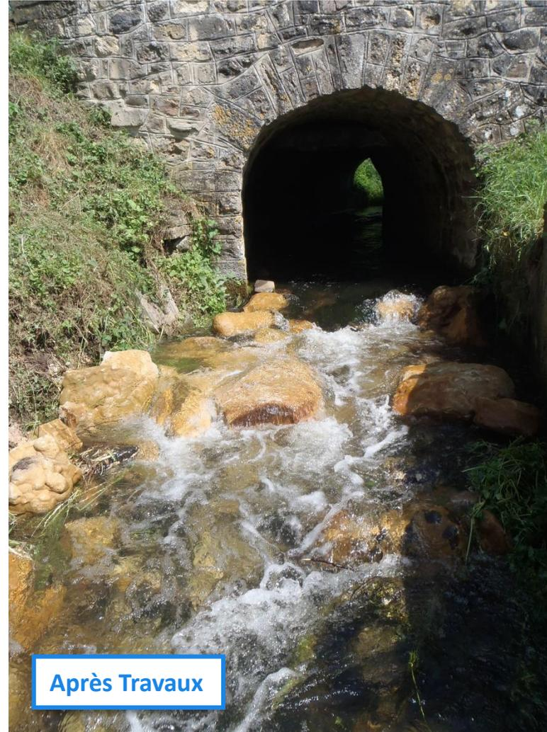
Amélioration de la franchissabilité piscicole par la mise en place de blocs et de microseuils en V inversé pour morceler la chute existante, au niveau du radier du pont
