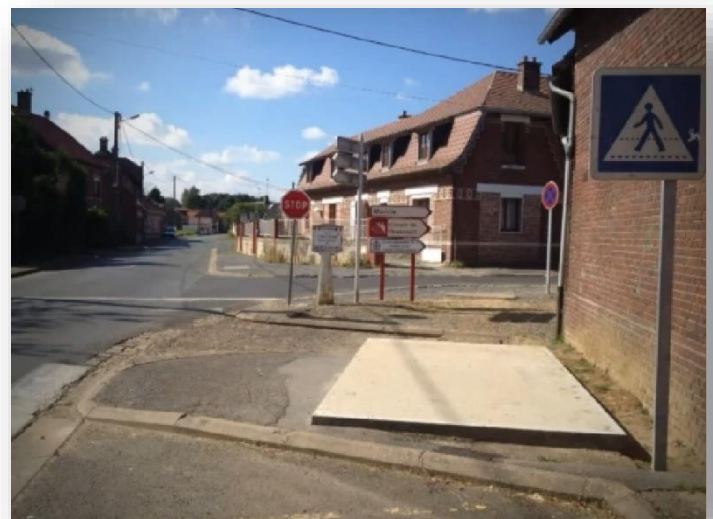
Ruisseau de la Broyette busé et enterré (Commune de Thiescourt)
