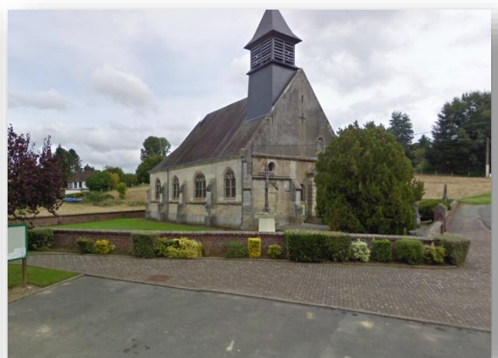
Ru d'Orval busé et enterré (Commune de Cannectancourt)
