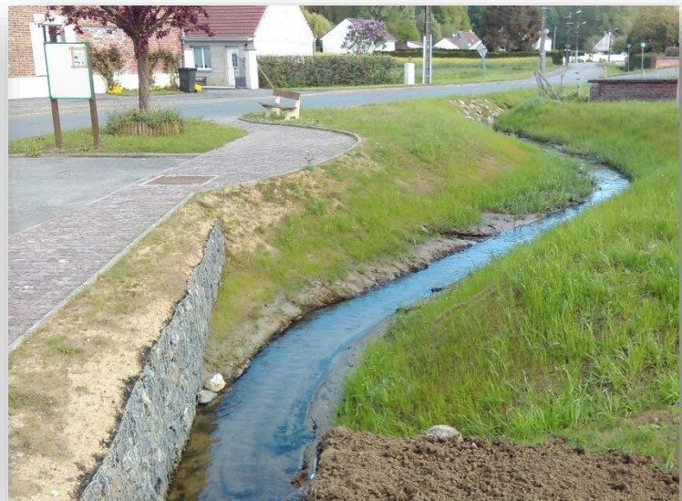
Remodelage du lit mineur et des berges et mise en place de gabions
