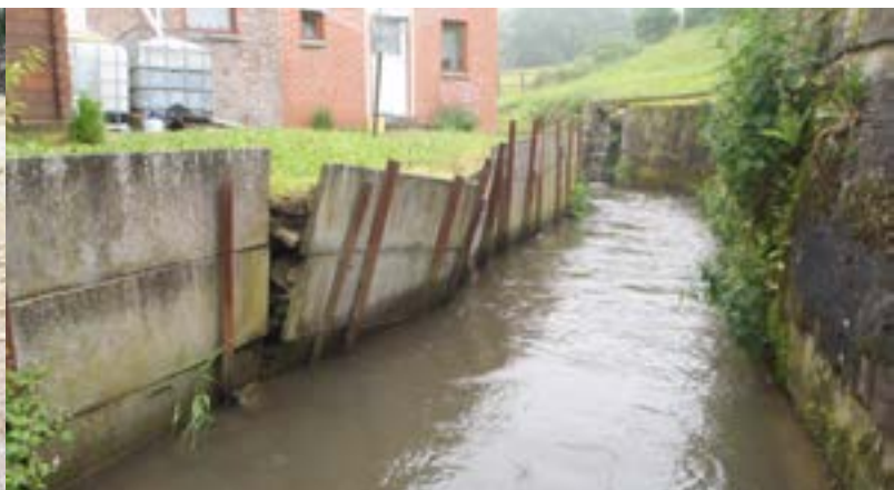
Protections de berges hétéroclites à base de béton
