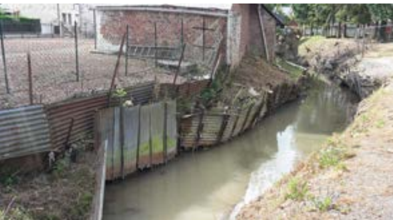
Berges artificielles en toles ondulées
