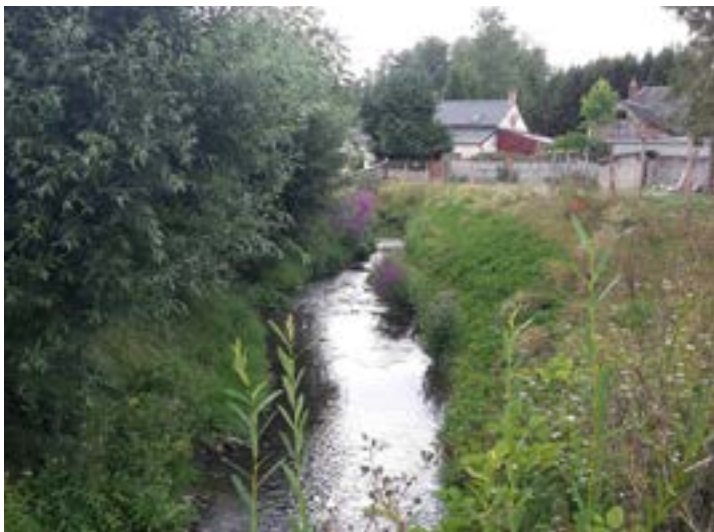
Ancienne Sambre 1 an après les travaux (2017)
