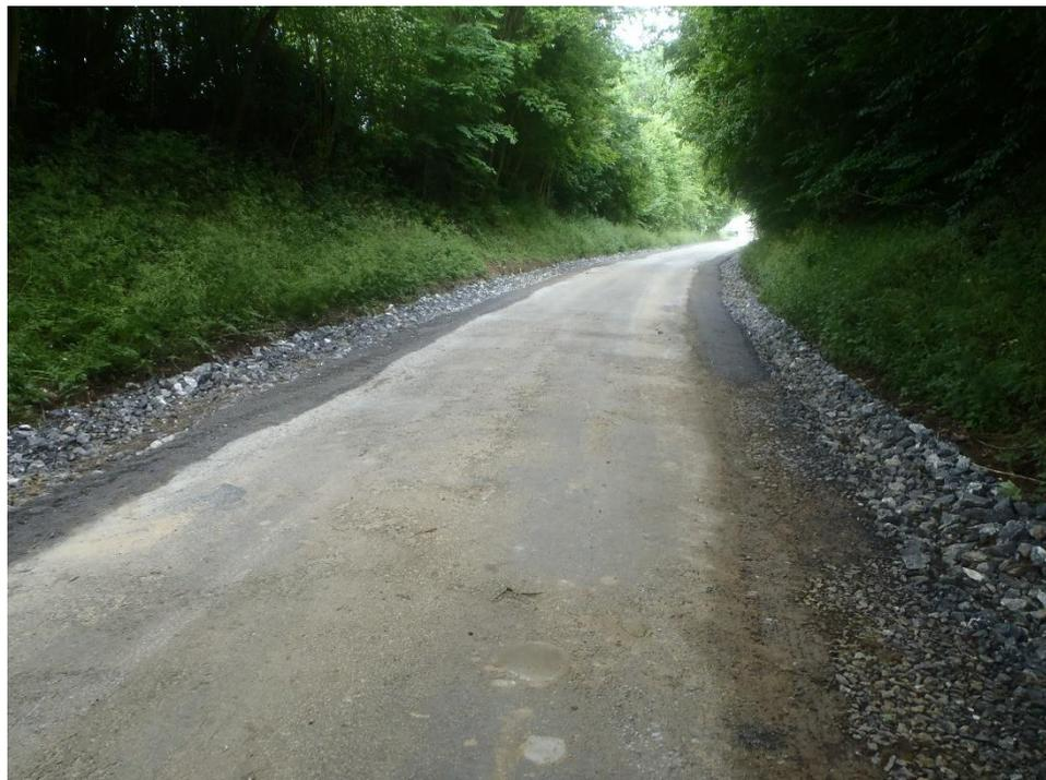
La mise en œuvre de la terre végétale dans les cunettes créées ne sera pas faite dans l'immédiat. Le maître d'ouvrage se laisse le temps de voir comment l'ouvrage se comporte jusqu'au mois d'août.
