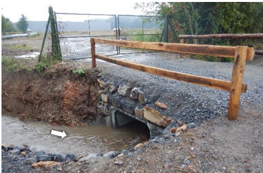
Pose de la deuxième lisse en bois
