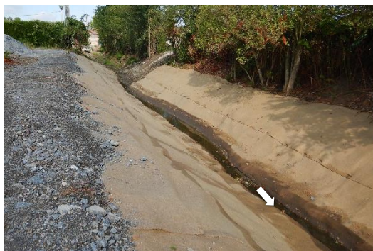
Bandes de géotextiles remises en place
