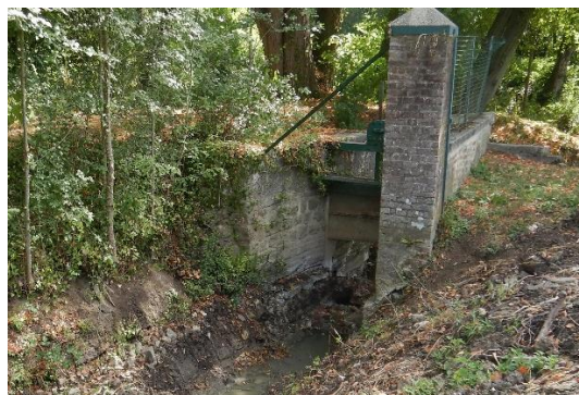
Arasement du radier béton
