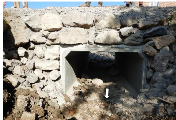
Mise en place d'un dalot après retrait du double busage
