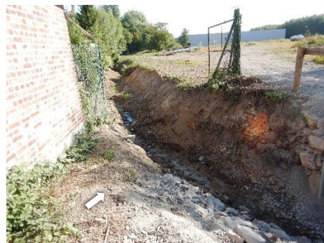
Adoucissement de la berge en rive gauche
