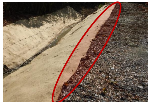
Mise en place de terre/graviers pour couvrir les jointures
