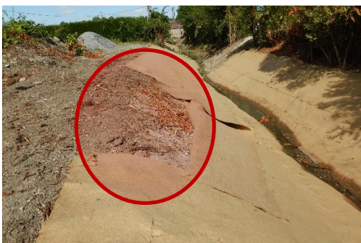
Reprise du géotextile
