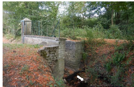
Vue aval du vannage
