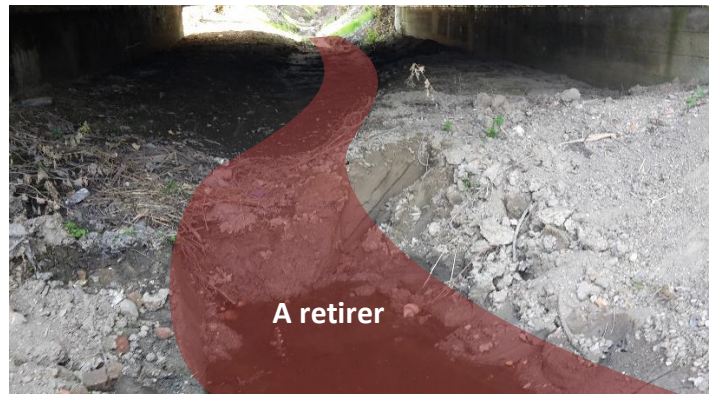
Retrait des sédiments uniquement sur la partie centrale du lit sous le pont
