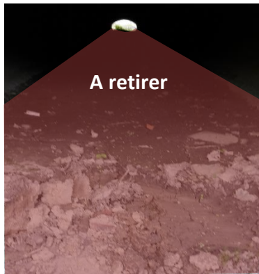
Retrait total des sédiments à l'intérieur de la section busée
