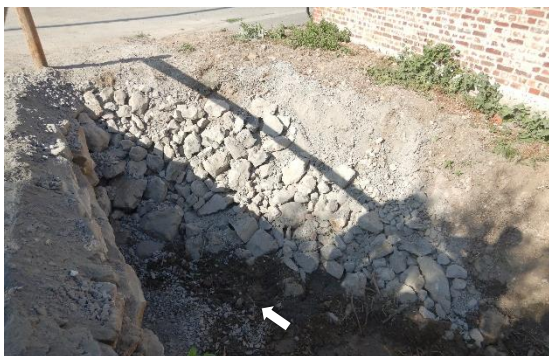
Berge stabilisée par empierrement
