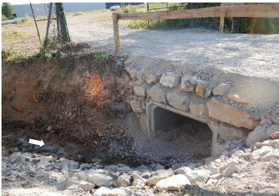
Mise en place d'un dalot après retrait du double busage
