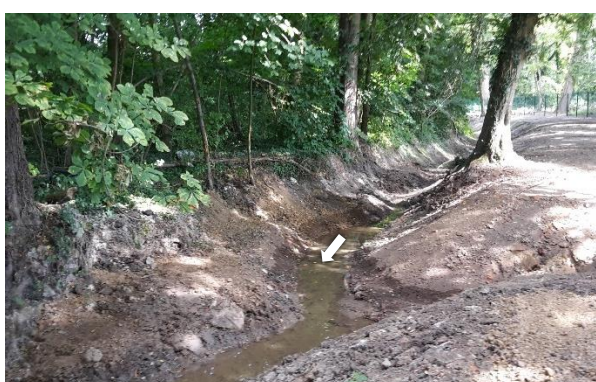
Site de l'ancien vannage totalement démantelé
