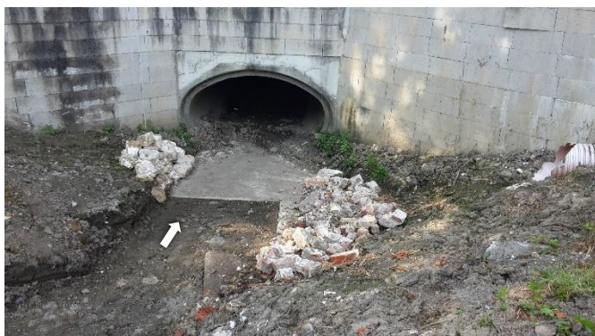
Mise en place de pierres en pieds de berges à recouvrir partiellement de terre
