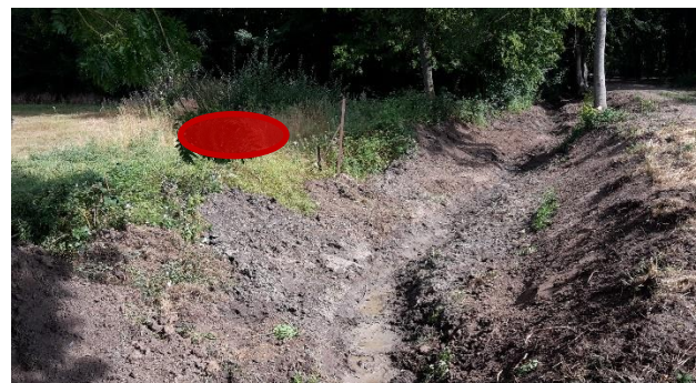
Site d'implantation de la fosse de captage d'eau
