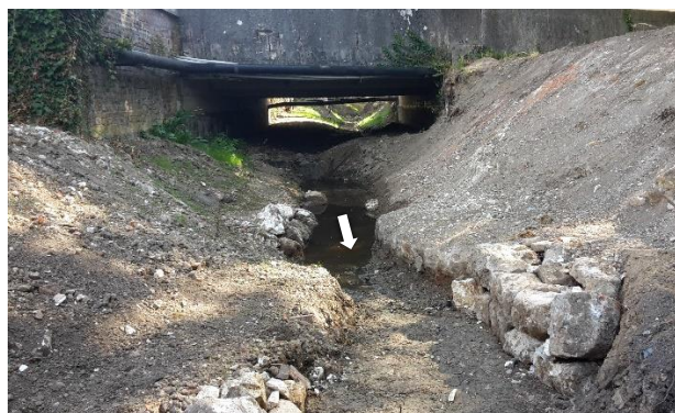
Banquettes réalisées et chenal central à curer sous le pont
