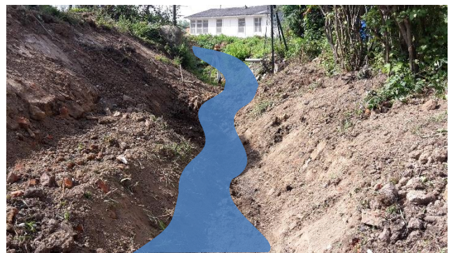
Démantèlement du 2 ème seuil : gravats à évacuer
