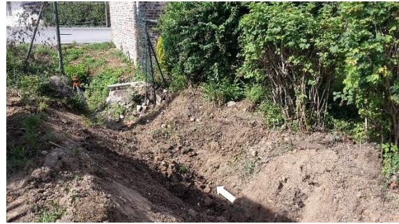
Reprofilage du lit et des berges après retrait de la végétation gênante.
