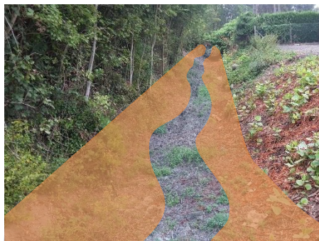
Secteur aval : reprofilage du lit et création de banquettes
