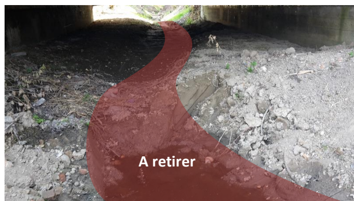
Retrait des sédiments uniquement sur la partie centrale du lit sous le pont
