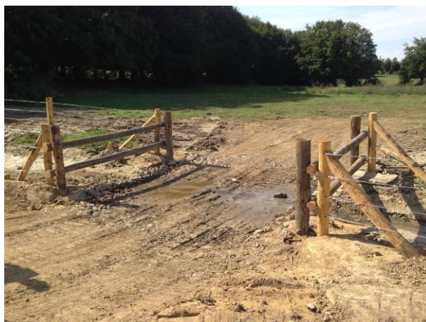
Passage à gué en cours de réalisation
