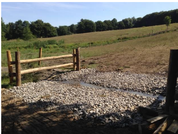
Passage à gué terminé sur affluent n°1
