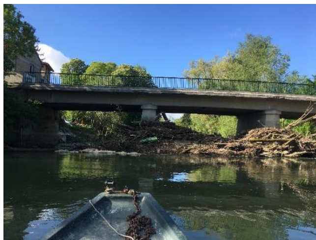
Embâcle sur le pont de Neufchâtel-sur-Aisne en 2018 (volume de 200 m 3 )
