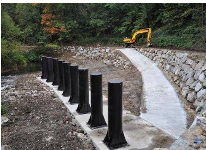
Photos du piège à embâcle à Annonay réalisé par le Syndicat des Trois rivières, source www.3rivières.fr
