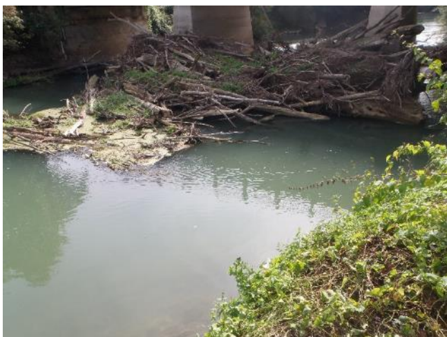
Embâcle sur le pont de Neufchâtel-sur-Aisne en 2016 (volume de 200 m 3 )
