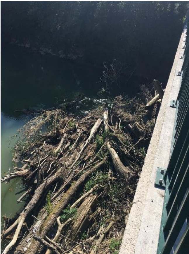
Embâcle au pont de Neufchâtel-sur-Aisne (volume estimé : 200 m3)
