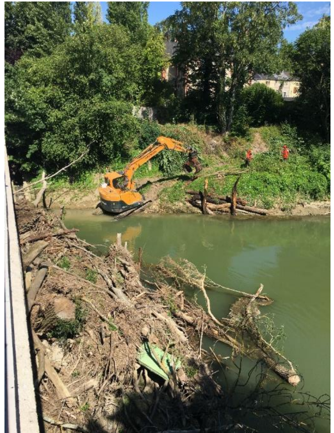
Intervention sur l'embâcle par l'entreprise MASCITTI NINO depuis la rampe d'accès en rive droite
