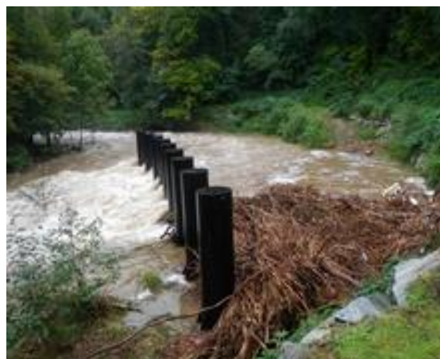
Photos du piège à embâcle à Annonay réalisé par le Syndicat des Trois rivières, source www.3rivières.fr
