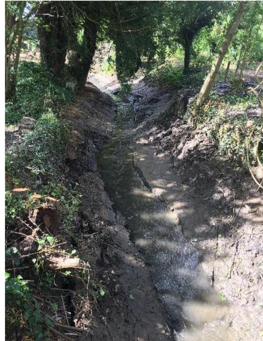
Retrait de l'ouvrage et extraction des sédiments accumulés
