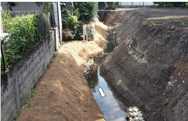
Berges et banquettes protégées par un géotextile en rive droite
