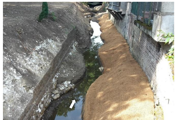
Berges et banquettes protégées par un géotextile en rive droite
