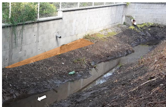
Reprise de la berge avec mise en place de terre
