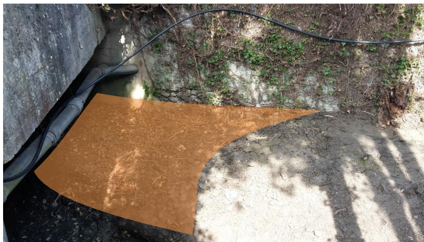
Apport de terre pour création de banquettes
