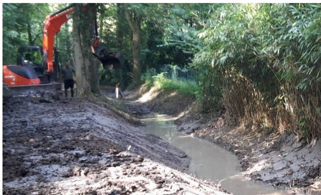
Poursuite des travaux vers l'aval
