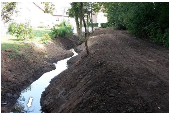
Reprofilage du lit et des berges sur le tronçon plus en aval
