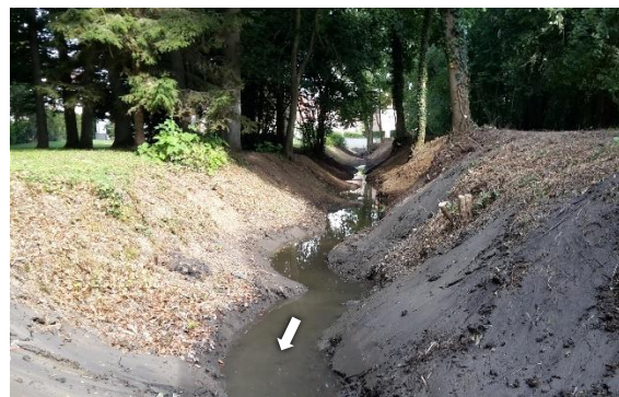
Reprofilage du lit et des berges sur le tronçon plus en aval
