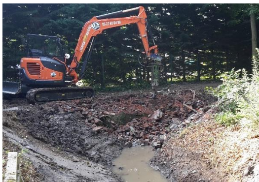
Démantèlement de l'ancien vannage
