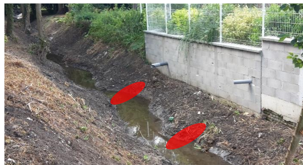
Mise en place de pierres en sortie de réseau d'eau pluviale.
