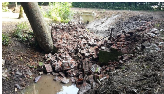
Démantèlement de l'ancien vannage
