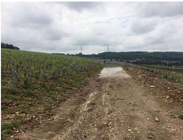
rétention d'eau sur le 115
