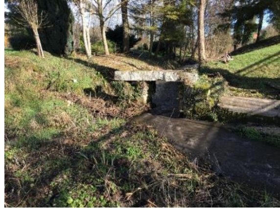
Ouvrage en mauvais état avec un risque de chute (avant travaux)
