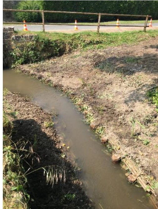
Création d'une fascine en rive droite en amont de la prise d'eau de l'étang de Muret
