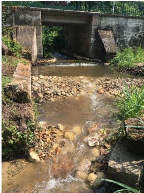
Mise en place de 2 micro-seuils
