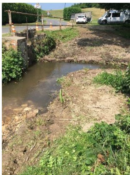
Vue aval de l'ouvrage (mai 2018)
