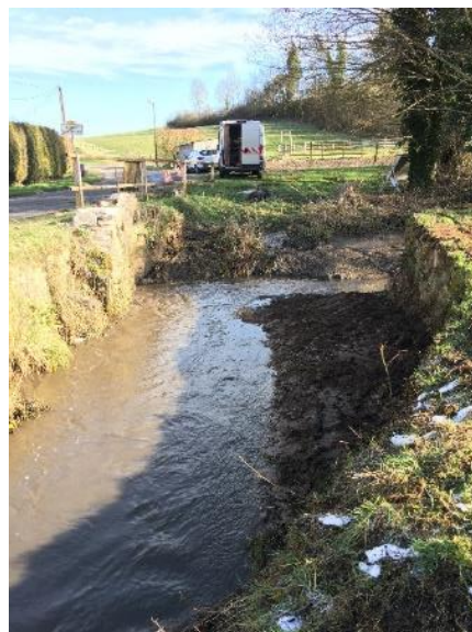
Effacement de l'ouvrage après travaux (février 2018)
