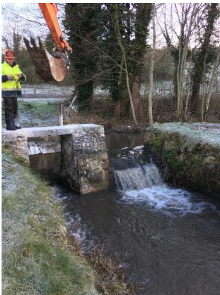
Ouvrage avant travaux (février 2018)
