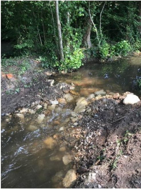
Mise en place de 7 micro-seuils
