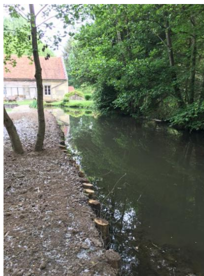
Mise en place d'une fascine de saule sur 30 ml
