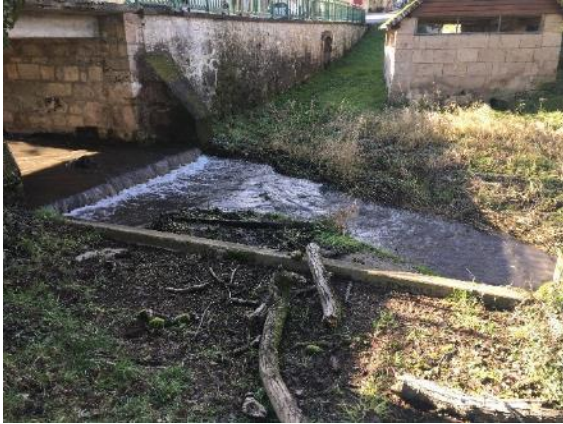
Radier du pont de la D482 (avant travaux)
