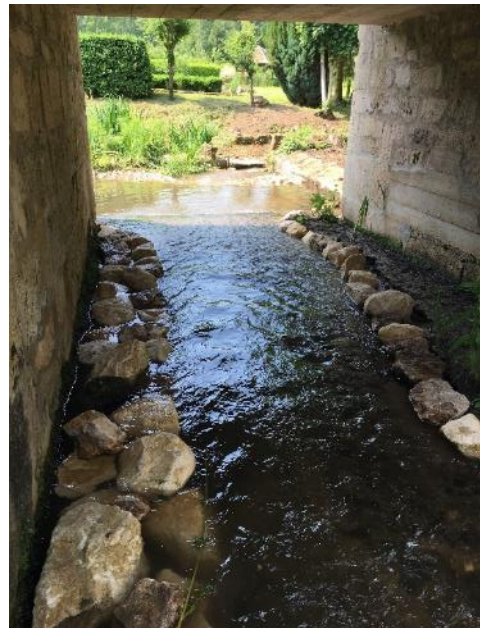
Création de banquettes sous le pont de la RD482
