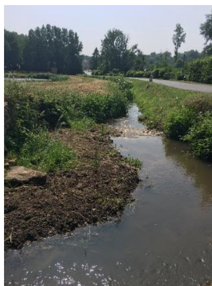
Vue amont de l'ouvrage (mai 2018)
