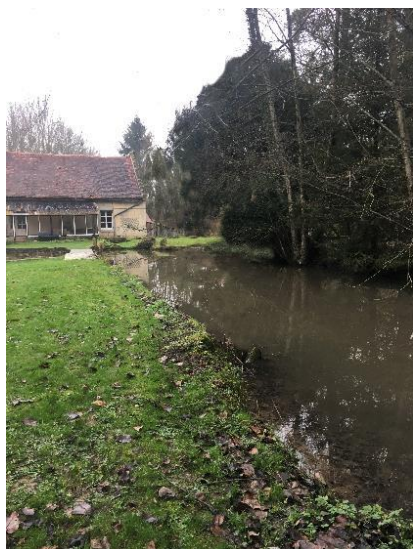
Berge avant travaux avec la présence de tôles en rive gauche
