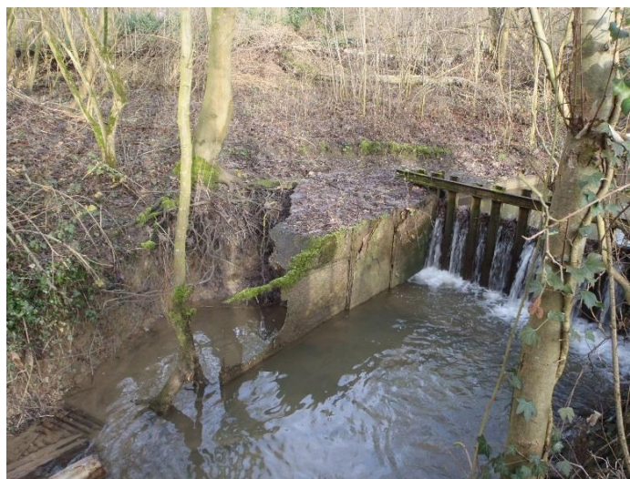
Seuil sur le bras de contournement (période de haute eau)
