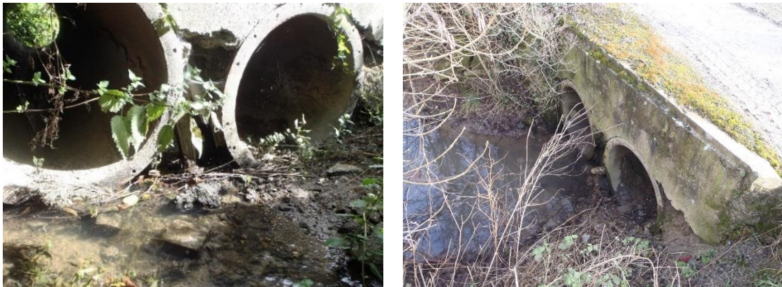
Buse mal calée et dégradation de sa structure
