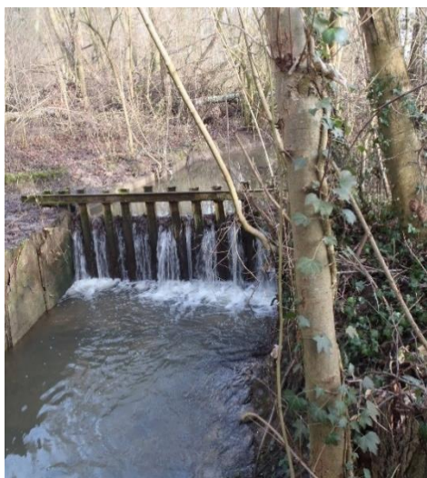
Seuil sur le bras de contournement (période de haute eau)
