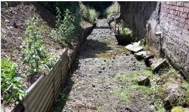
Secteur amont : lit à reprofiler et banquettes à créer
