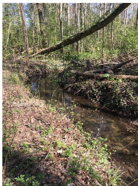
Photo après travaux (Tronçon 2.HAU.1)
