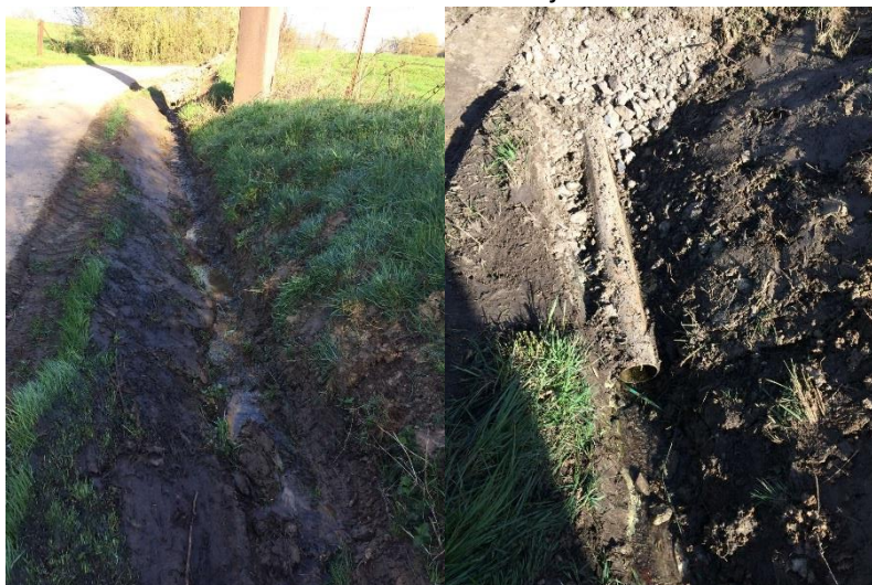
Vue de la cunette créée en amont du ruisseau et de sa jonction avec la canalisation existante
