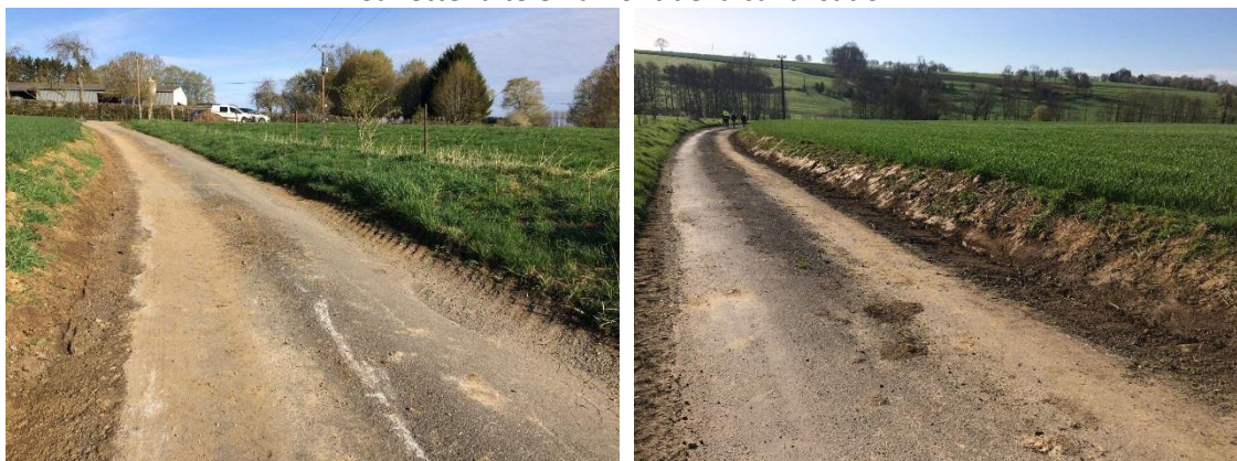
Cunette faite en amont de la canalisation
