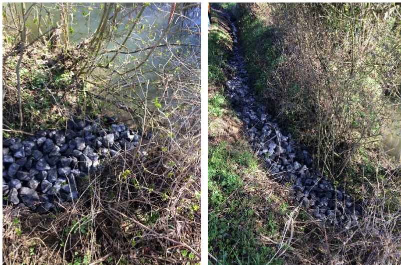
Jonction du fossé en aval de la canalisation traversant la voirie avec le ruisseau
