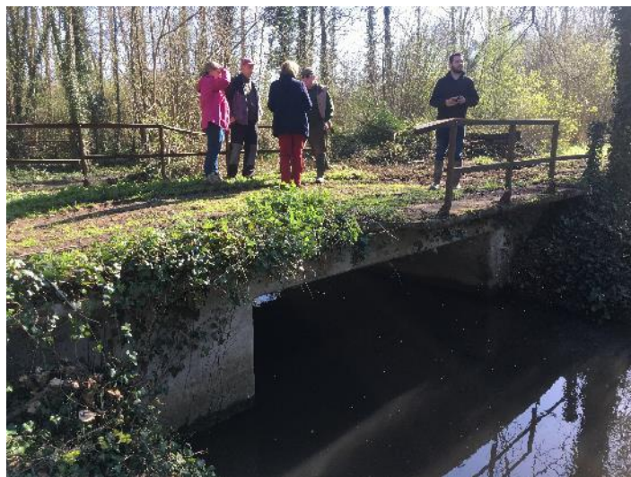
Photo de la passerelle
