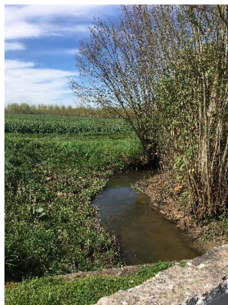
Photo après travaux (Tronçon 3.FCR.3)
