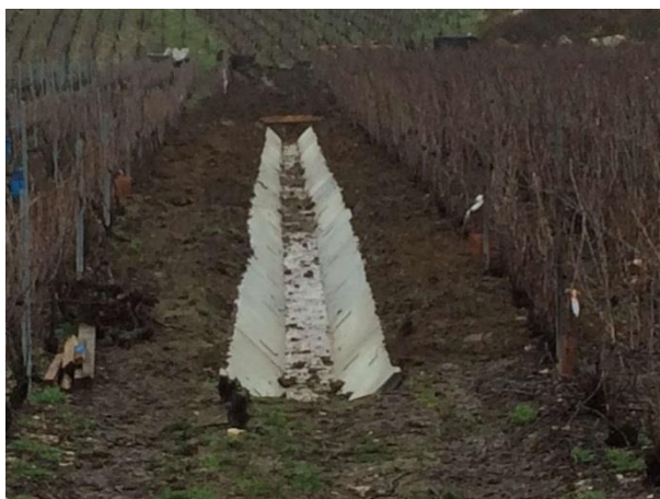
Vue sur une proposition de redents « brise énergie » pour les caniveaux en béton (principe fait avec une cale en bois d'une dimension égale à une bordurette de 25 cm*20 cm*8 cm).
