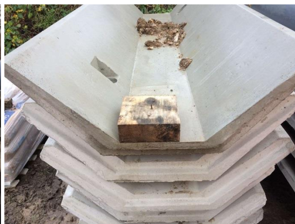
Vue sur une proposition de redents « brise énergie » pour les caniveaux en béton (principe fait avec une cale en bois d'une dimension égale à une bordurette de 25 cm*20 cm*8 cm).
