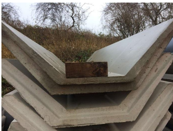
Vue sur une proposition de redents « brise énergie » pour les caniveaux en béton (principe fait avec une cale en bois d'une dimension égale à une bordurette de 25 cm*20 cm*8 cm).
