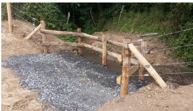
Après travaux : abreuvoir rustique
