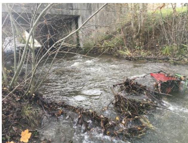
Création de micro-seuil en aval du radier du pont
