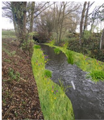
Aménagement de banquettes d'hélophytes (scénario prévu)
