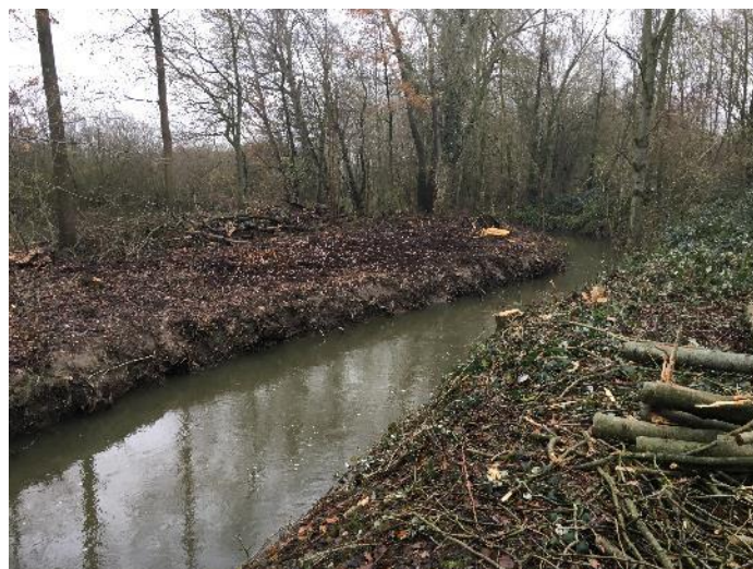
Evacuation d'un embâcle sur le tronçon de l'ADERMAS, tronçon OMBV
