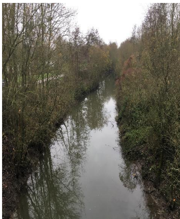
Tronçon OMBX après travaux
