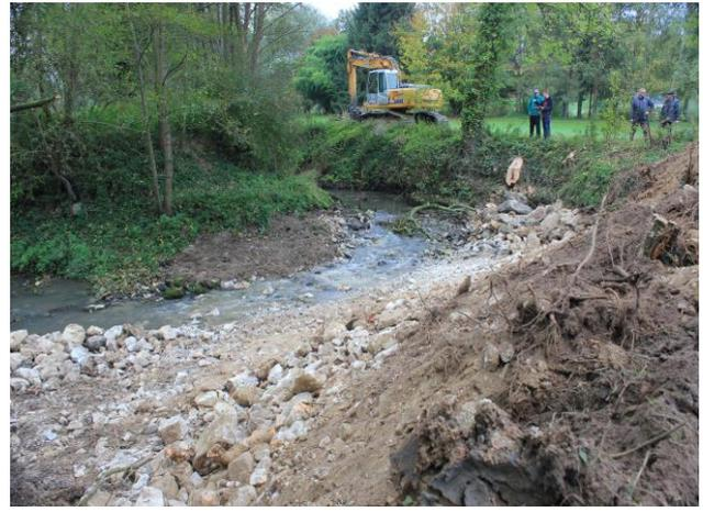
Comblement de la fosse de dissipation, talutage de la berge rive gauche en pente douce
