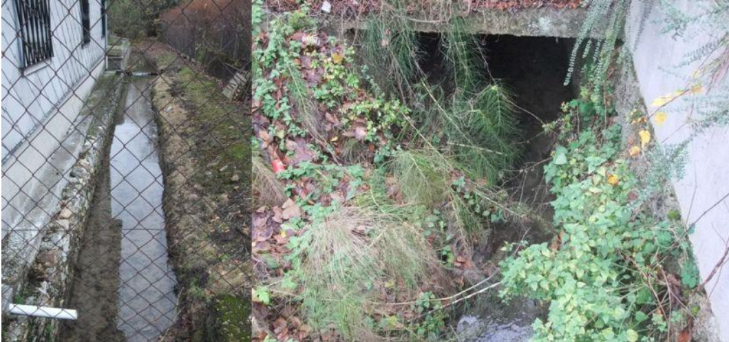
Photo 9 : Ru de Nesles dans sa section jardinée montrant l'artificialisation du lit et l'envahissement par la végétation
