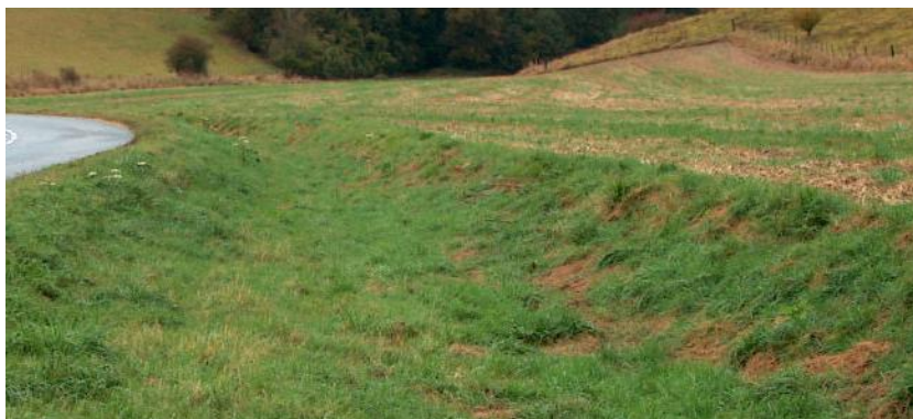
Figure 29 : Exemple de noue enherbée
