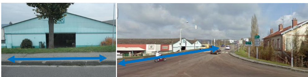
Photo 7 : Passage de la section busée le long de l'avenue Montmirail
