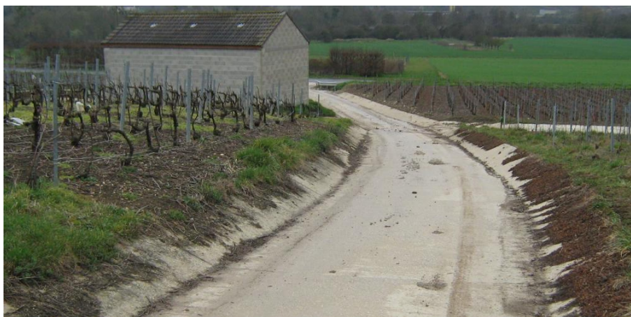
Figure 33 : Exemple de chemin en béton reprofilé
