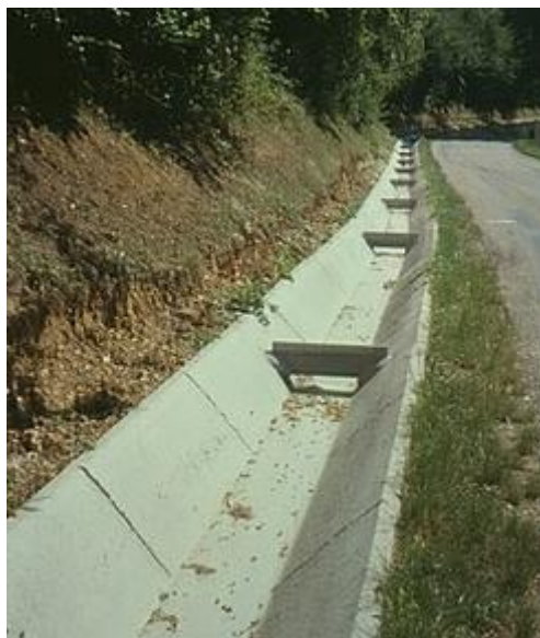
Figure 36 : Exemple de caniveau béton trapézoïdal à redents
