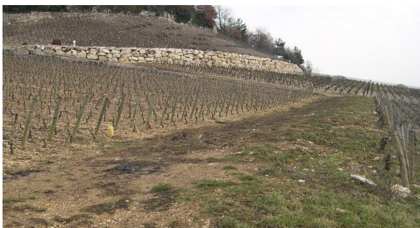
Figure 31 : Exemple de chemin reprofilé à contre-pente
