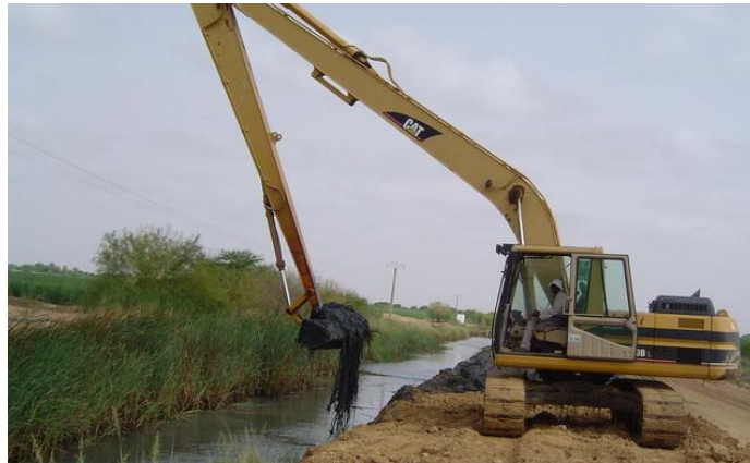
Photo 11 : Curage d'un fossé
