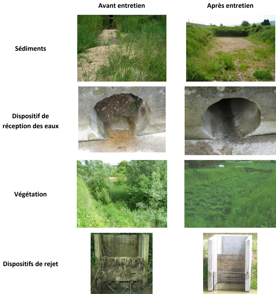
Photo 10 : Entretien des ouvrages de tamponnement
