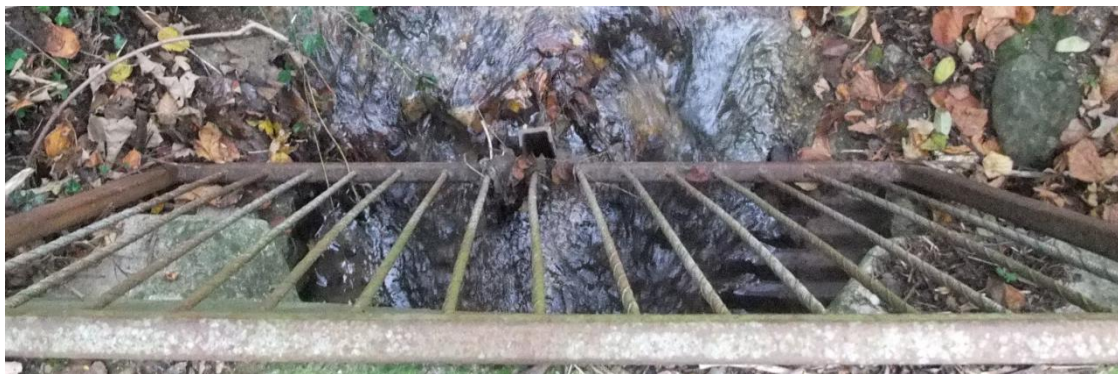
Photo 6 : Entrée de la section busée au niveau de l'avenue Montmirail
