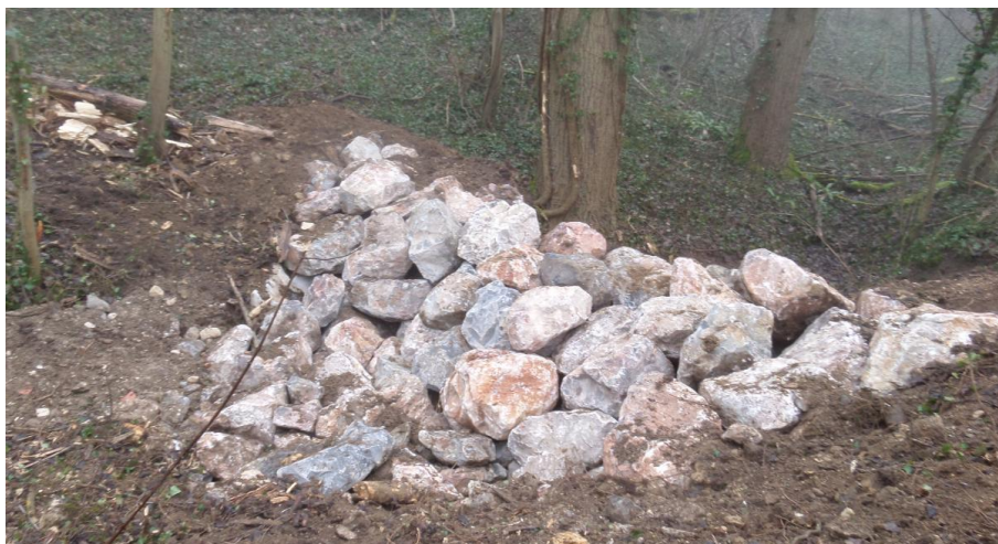
Figure 24 : Exemple de seuil en enrochement
