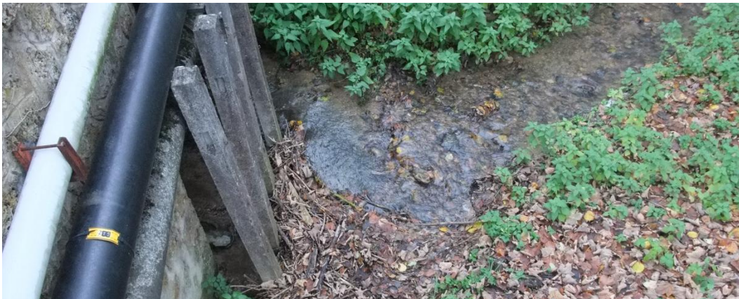
Photo 5 : Ouvrage de franchissement de la RD866 avec aménagement favorisant le dépôt des sédiments
