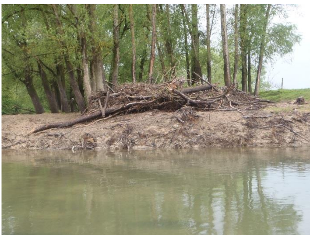
Avant travaux : embâcle N°12 sur la commune de Pargnan
