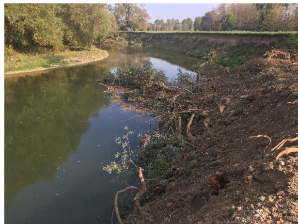
Après travaux : création d'un épi avec fixation de l'embâcle (pieux + ligature) pour protéger la berge en aval
