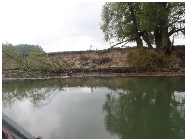
Avant travaux : embâcle N°13 sur la commune de Pargnan
