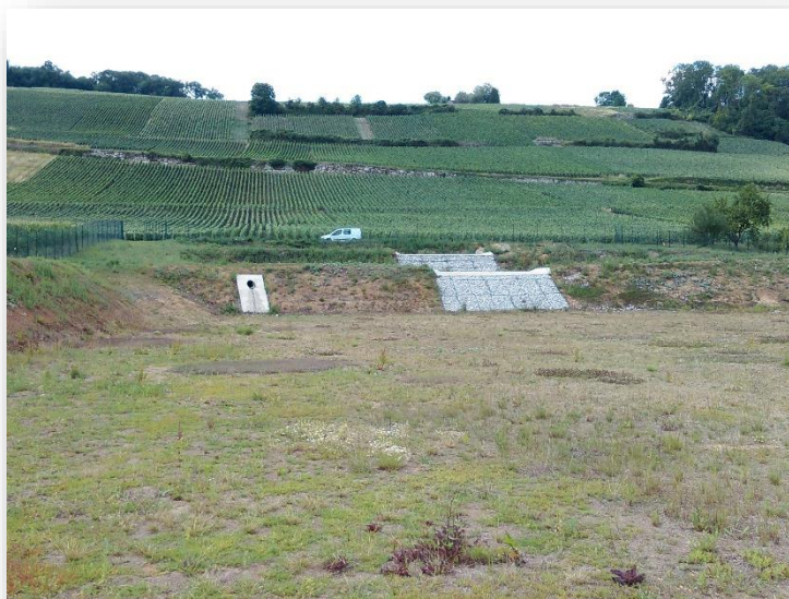
Bassin de décantation de 5300 m 3 , collectant les eaux de ruissellement d'un bassin versant de 131 ha
