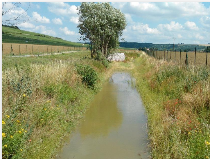
Bassin de décantation de 3000 m 3 , collectant les eaux de ruissellement d'un bassin versant de 92 ha
