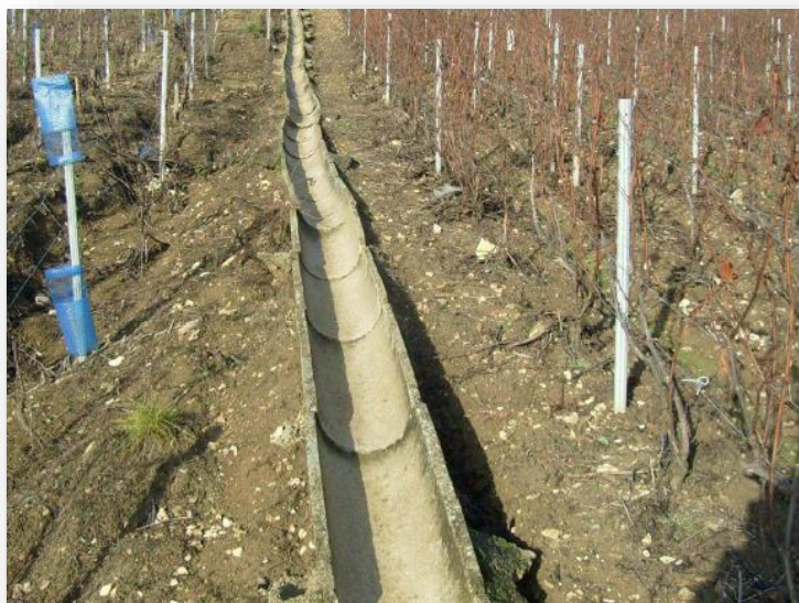
Mise en place de coquilles bétonnées entre les rangs de vignes
