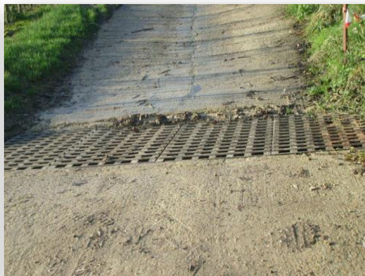
Mise en place de dépierreurs et de chemins bétonnés
