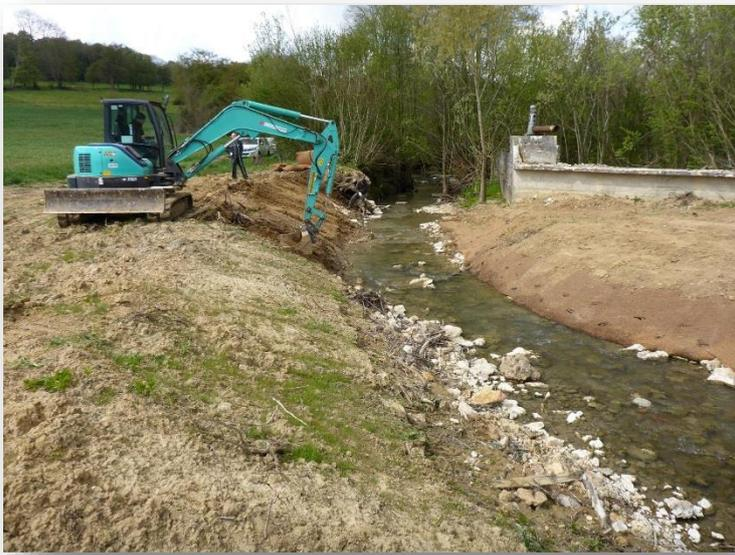
Reprise du terrassement et mise en place d'un géotextile ensemencé
