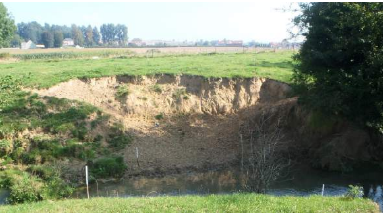
Effondrement de berges et absence de végétation rivulaire
