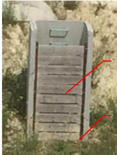
Ouverture de 3 cm pour passage de l'eau et blocage des flottants
