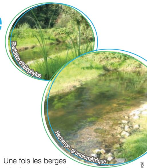
Une fois les berges talutées en pente plus douce et le lit d'étiage redessiné (largeur comprise entre 2 et 3 m), une recharge granulométrique de 80 m<sup>3</sup> de matériaux calcaires (diamètre 0-150 mm) a été opérée sur les 520 m linéaire du nouveau lit. L'ensemencement des berges et la plantation de 2 000 pieds d'hélophytes sont venus finaliser les travaux au début du mois d'août.
