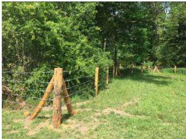
Clôture posée le long du Lerzy (tension des fils à réaliser)
