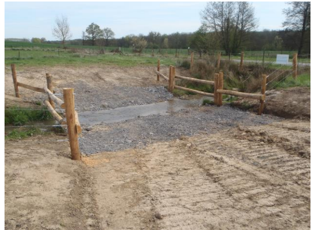
PASSAGE A GUE AVANT ET APRES REALISATION
