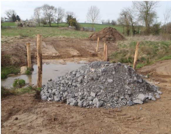
PASSAGE A GUE AVANT ET APRES REALISATION
