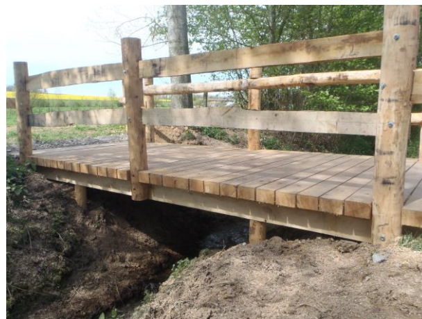
PASSERELLE BOIS PERMETTANT LE FRANCHISSEMENT DES ANIMAUX
