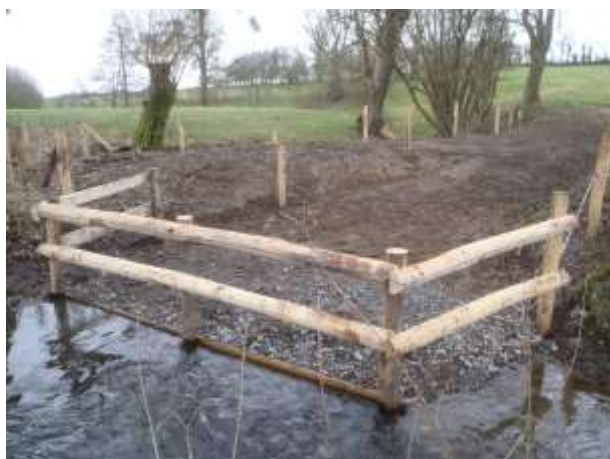
ABREUVOIR RUSTIQUE TERMINE
