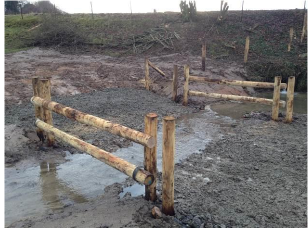
TRAVAUX DE CLOTURE ET POSE D'UN PASSAGE EN GUE EN COURS, PATURE 16
