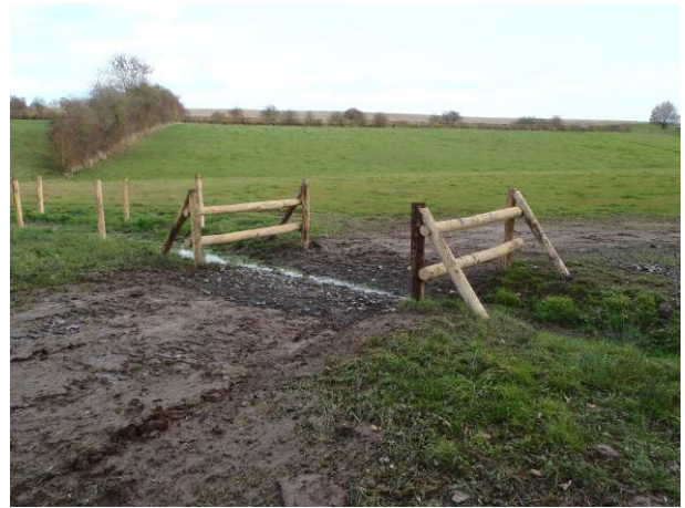
PASSAGE A GUE ET PROTECTION DU RUISSEAU
