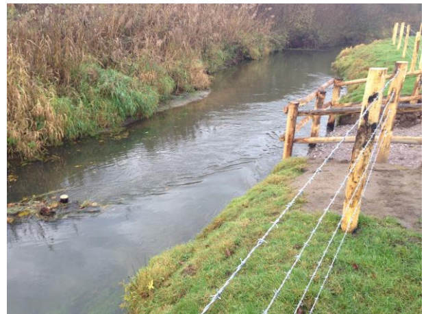
Abreuvoir, clôture et épi réceptionnés
