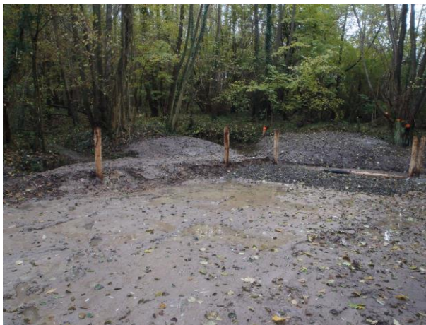
POSE DES PIQUETS ET BASTAING DE PIED
