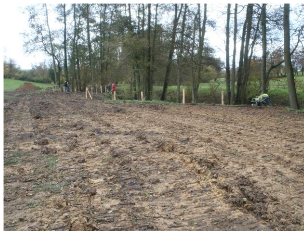
POSE DE LA CLOTURE (EN COURS)
