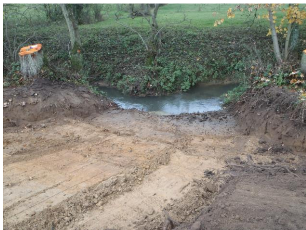
TERRASSEMENT DE LA ZONE D'ABREUVEMENT
