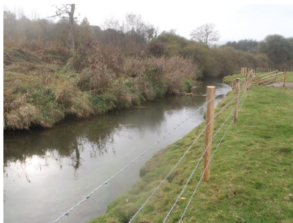
Clôture en cours de montage
