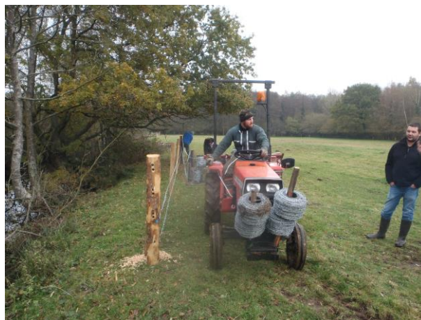
Déroulage des baillages en cours
