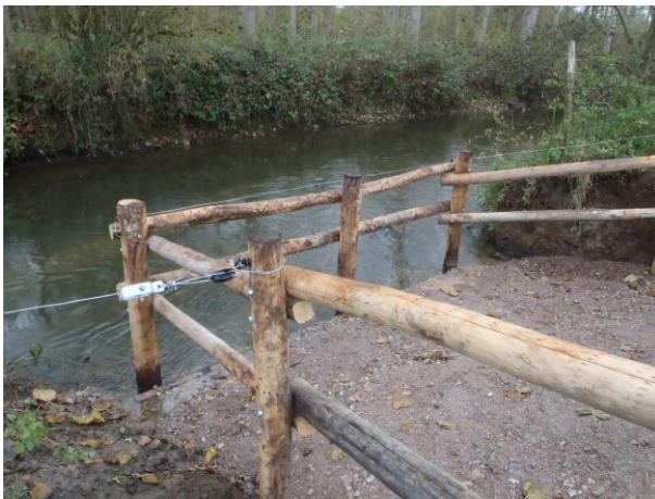
Empierrement de l'abreuvoir rustique
