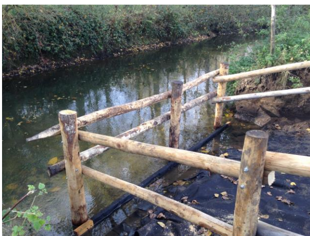
Recoupe des lisses et pose des cailloux à venir
