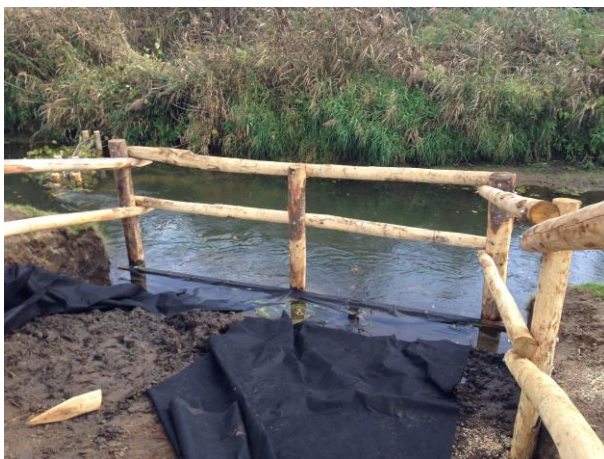
Abreuvoir rustique en cours de réalisation
