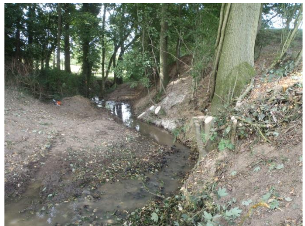
Abattage des arbres penchants sur berges abruptes
