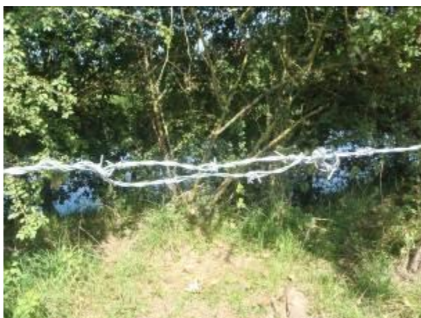
Jointure de baillage peu soignée
