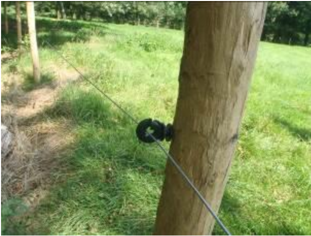
Remplacement des isolateurs
